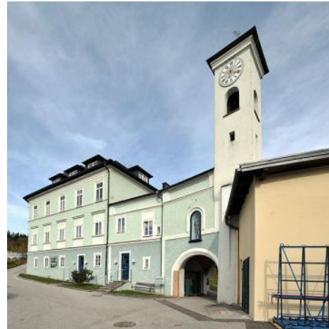
Das ehemalige Messinghammer-Betriebsgebäude in Oberalm
