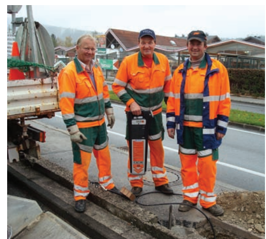
Bild: Der zweite Abschnitt wird saniert.
